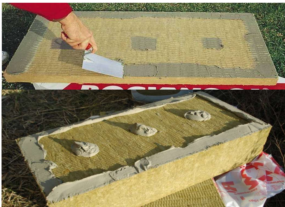
Obr. 4: Nanášení lepicí hmoty pomocí obvodového pásu
