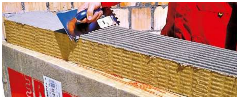
Obr. 5: Celoplošné nanášení lepicí hmoty
